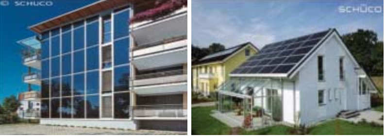
අනාගත ලෝකයේ ඉදිවන ගොඩනැගිලි වල බිත්ති සහ වහලවල් මත මෙසේ සූර්ය පැනලයන් සවි කෙරෙනු ඇත
