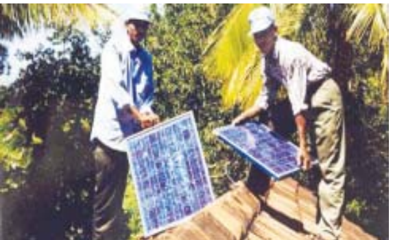
ග්‍රාමීය නිවසක වහලය මත සූර්ය පැනල සවිකරන කාර්මිකයින් දෙදෙනෙක්
